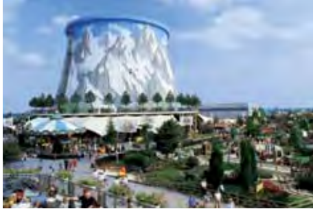
Koeltoren 1998 - 1999 Kalkar (DE) 50m x 300m
